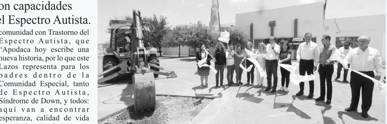
Dando el Banderazo de arranque de obra aparece al centro de la gráfica el C.P. César Garza Villarreal, Alcalde de Apodaca acompañado por funcionarios municipales y vecinos de la localidad
